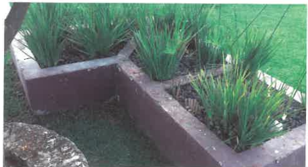
Biofiltro de una casa habitación para 6 personas, el tiempo de uso es de 3 años y la salida de agua se utiliza actualmente para el riego del pasto.
