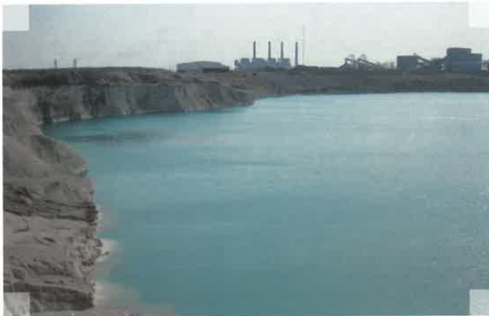
Fotografía 5. Planta lavadora de carbón y entrega a las termoeléctricas de la Comisión Federal de Electricidad
