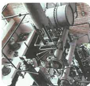
Laboratorio de Ingeniería Térmica Aplicada - UAEM
